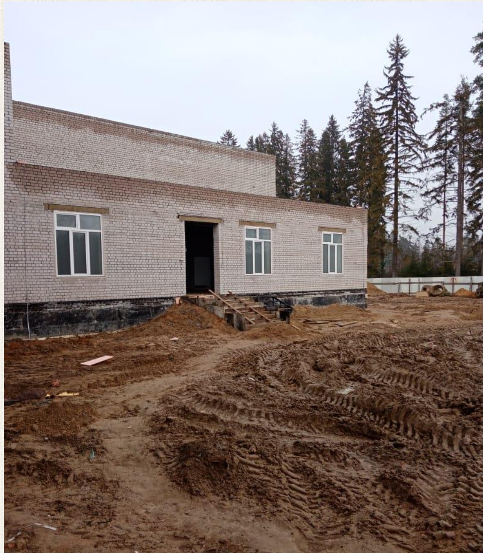
Строительство пристройки Сосновского центра образования
