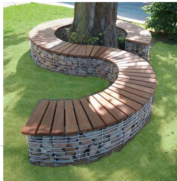
Скамья с конструкцией из габионов
